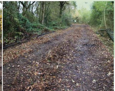
Les travaux d'aménagement de l'ancienne voie ferrée en boucle verte cyclable et piétonne, reliant Montreuil-Juigné à Angers, vont démarrer courant mars ou avril. Au préalable, en fin d'année, Réseau ferré de France a procédé au démontage des rails. Les traverses en bois ont été retirées pour être traitées à la déchèterie de Villechien. Les travaux, menés par Angers Loire
