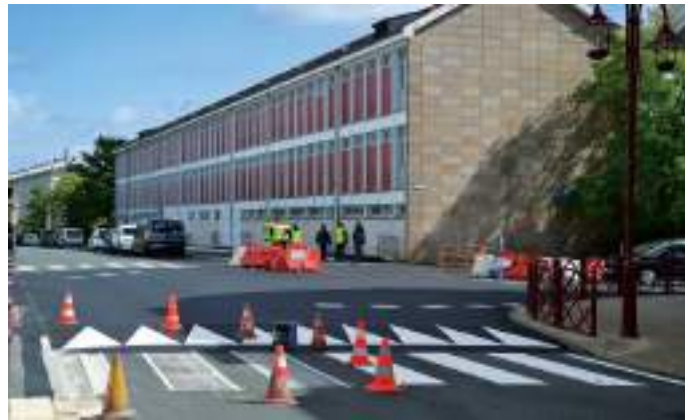
Aménagement des abords du collège pour sécuriser et fluidifier la circulation
