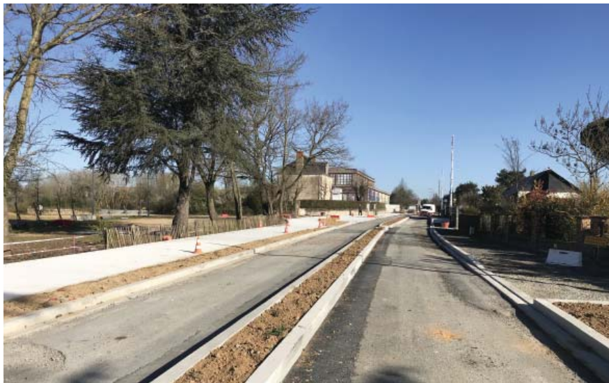
La phase n°2 du chantier de la rue V. Hugo a débuté mi avril avec l'ouverture de l'avenue de l'Europe et le nouveau giratoire.
