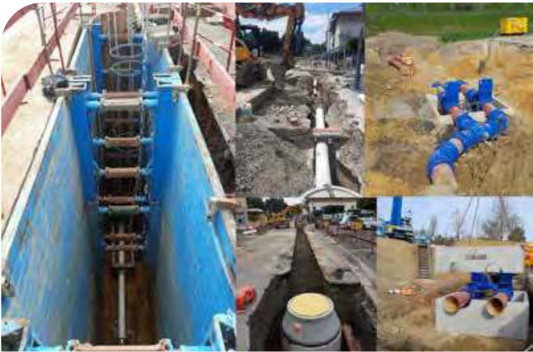
Réhabilitation en tranchées et par éclatement du réseau de la rue de la Granges aux Belles à Beaucouzé et ouvrages du siphon sous A11 à Avrillé)
