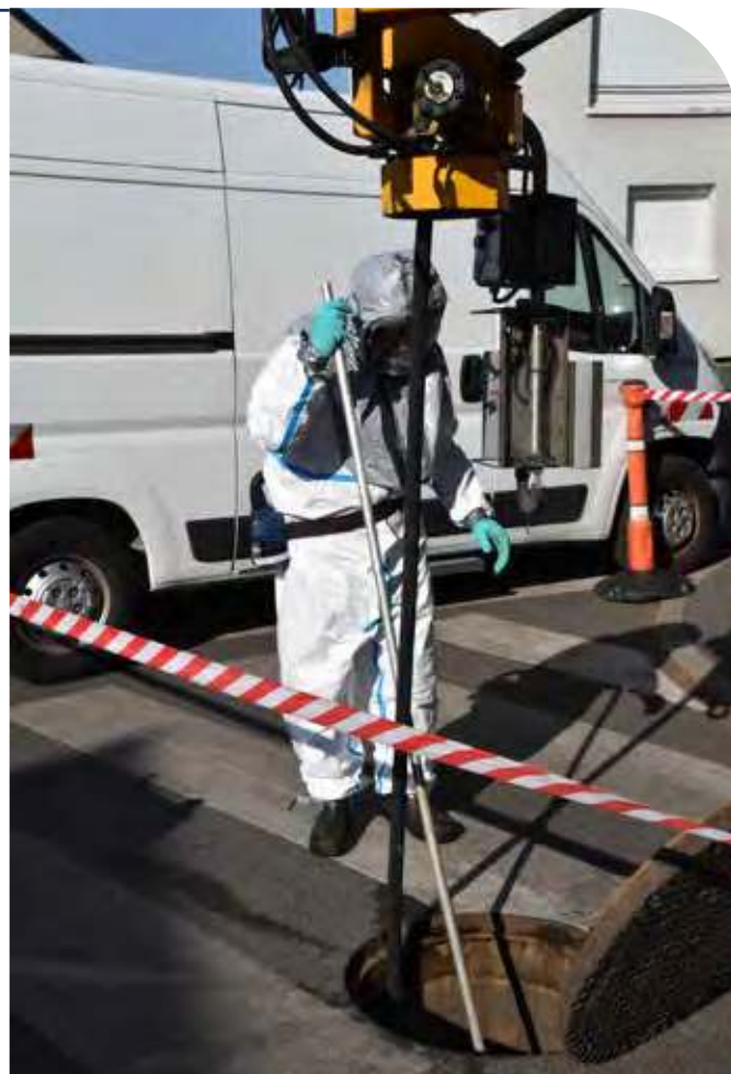
Intervention curage avec protocole amiante
