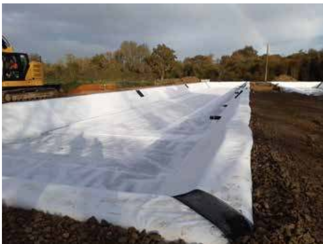
Reconstruction de la station d'épuration du bourg de Soulaines sur Aubance par filtres plantés
