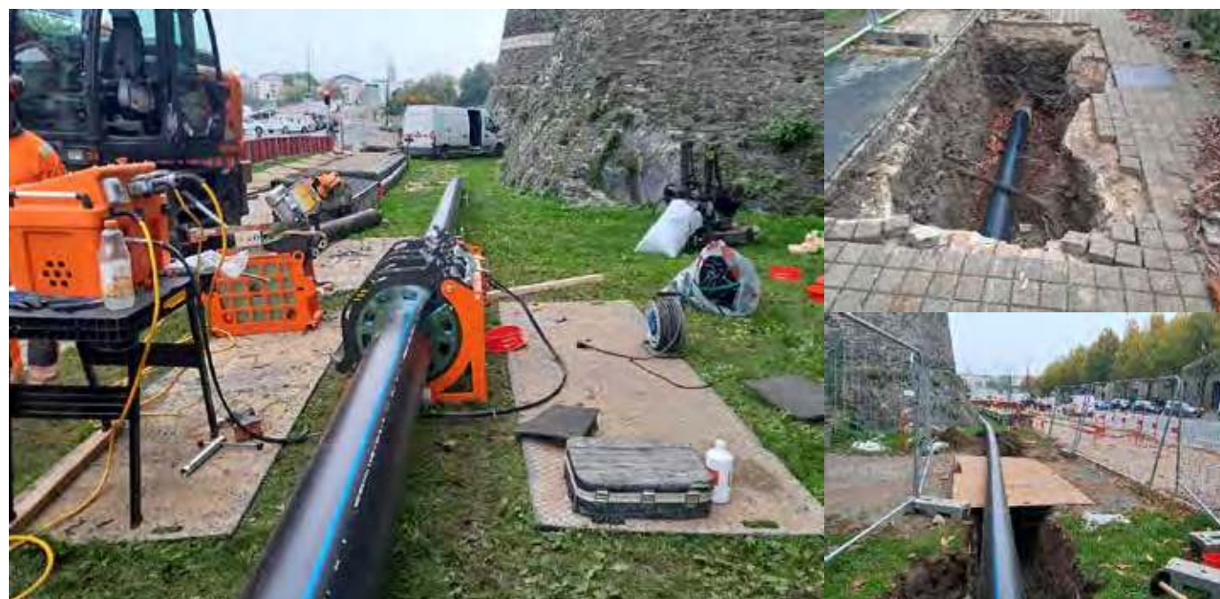
Tubage de la conduite de distribution – Avenue de Gaulle – Angers)
