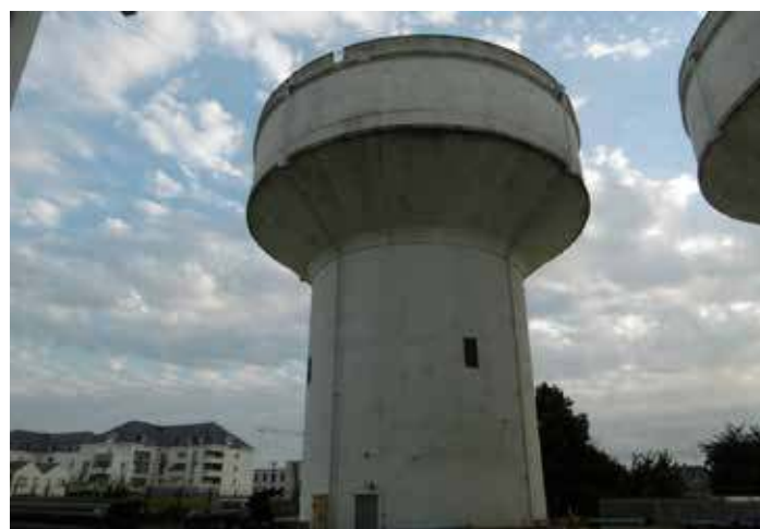
Réservoirs sur tour de Berry
