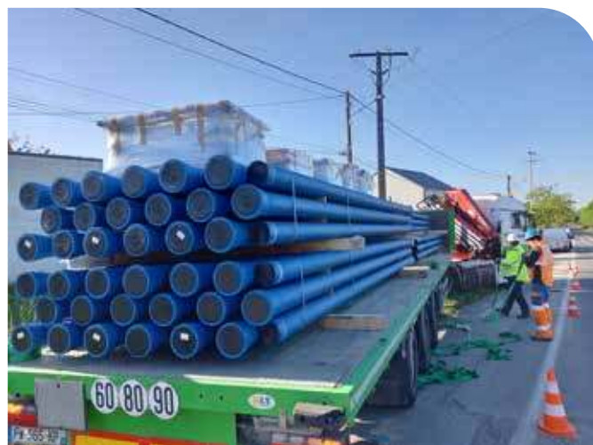
Contrôle de livraison directe sur chantier.
