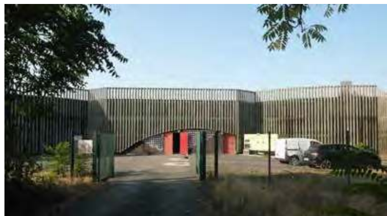
Réservoirs semi-enterrés de La Belière
