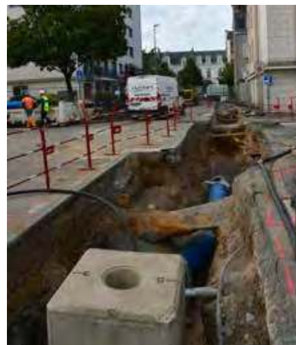
l Début des travaux rue Louis Gain
