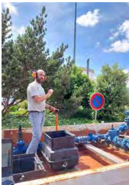
Réparation Pont du Louet – Ponts de Cé
