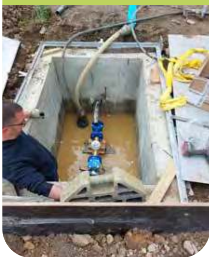
Branchement nouvelle résidence
